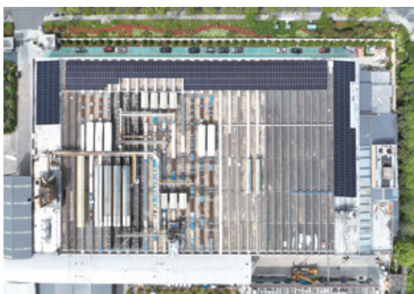
現時廠區屋頂
