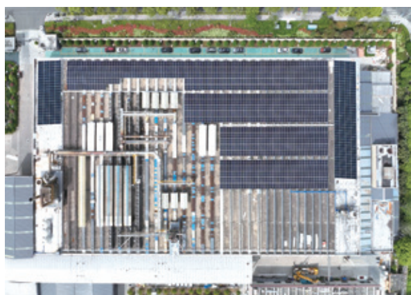
光伏項目完工後廠區屋頂
